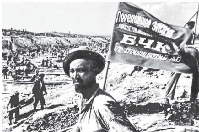
Строительство Большого Чуйского канала.
