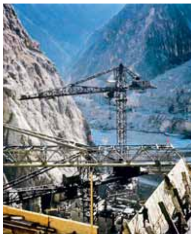
Строительство Токтогульской ГЭС
