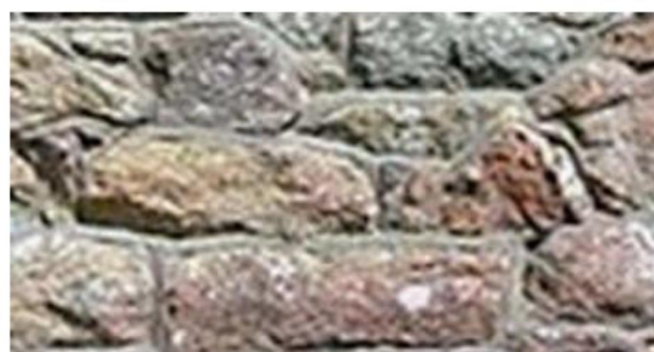
б) кладка строительным раствором
